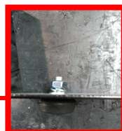
2 Montáž opěry. Podle obrázku pomocí 6HR matice M10, ploché podložky a pružné podložky namontujte pryžové opěry.
